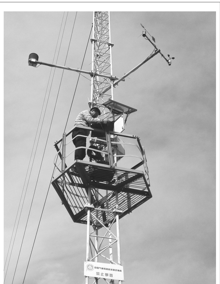
近日，沈阳区域气候中心技术人员历时9天完成了辽宁省风能资源观测网8座测风塔的安全巡检、维修、更换了部分测风塔的风观测传感器，保证了风能资源观测网的安全运行和观测数据的有效性、准确性和连续性。
